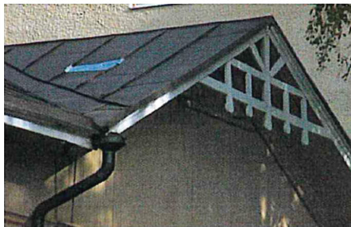
Laudoitus on revennyt kuvetaitteen kohdalla.
