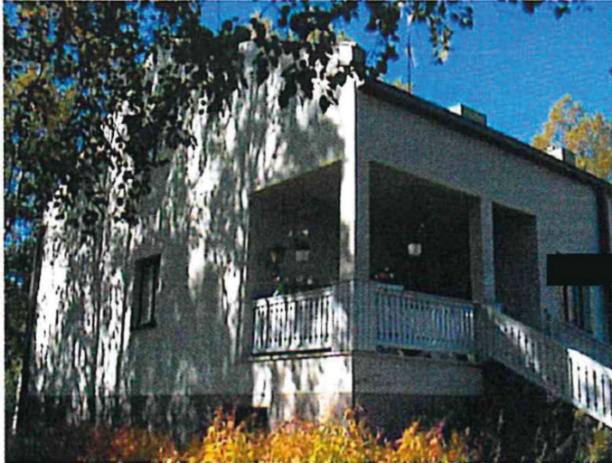
Avokuistien ja portaiden kaiteet on uusittu.
