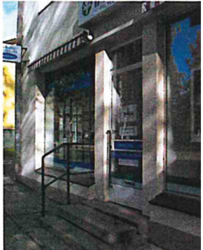
Laajennusosan teräsrakenteinen ovi 1950-luvulta
