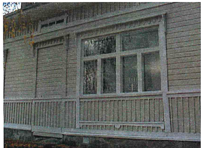
Liiketilan oviaukkoja näyteikkuna on taitavasti täytetty
