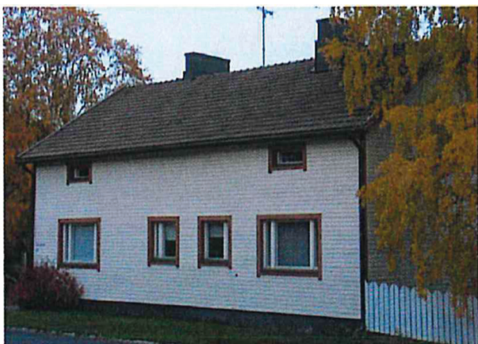
Rakennuksessa on vielä tiilikatto
