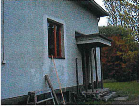
Itäpäädyn uusi ikkuna,
