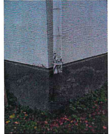
Syöksytorvet ovat liian lyhyet
