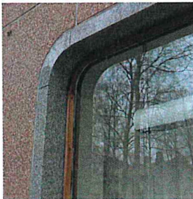
Pankin pyöristetty ikkuna
