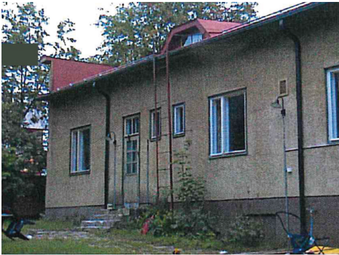
Kaarlonkatu 10 pihanpuolen julkisivu
