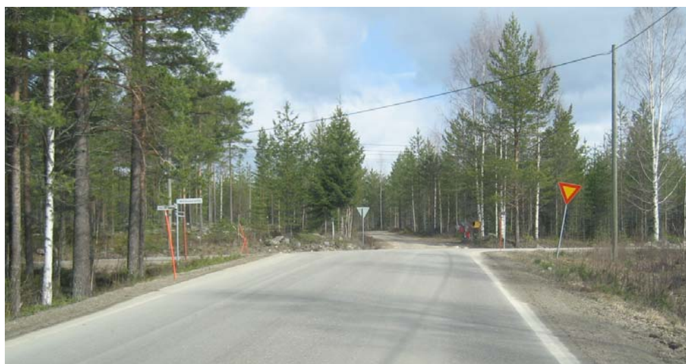
Kuva 28. Höljäkätien (5261) ja Mätäsvaarantien liittymä.
