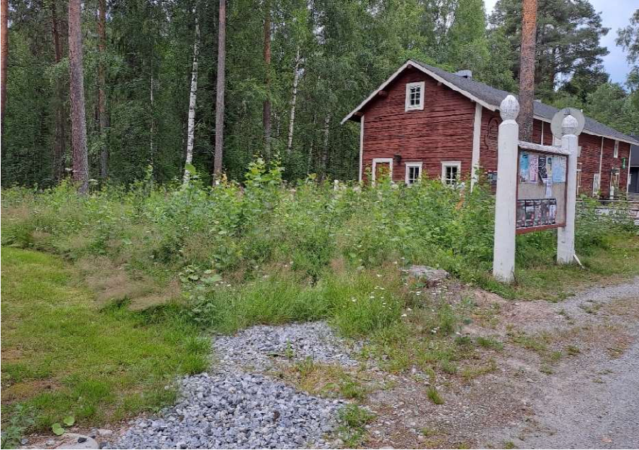
Bomban torin ympäristö on viimeistelemätön murskekasoineen ja, hoitamattomine vesakoineen.
