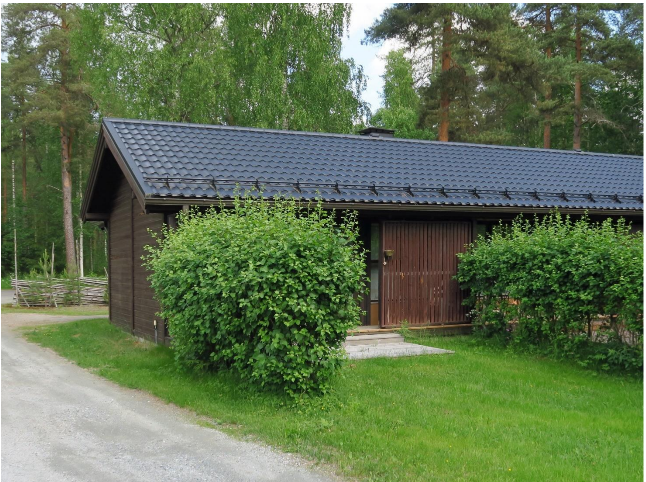
Kuva 51. Rakennuksen yksityiskohtia: räystäsrakenne ja rimayksityiskohtat.
