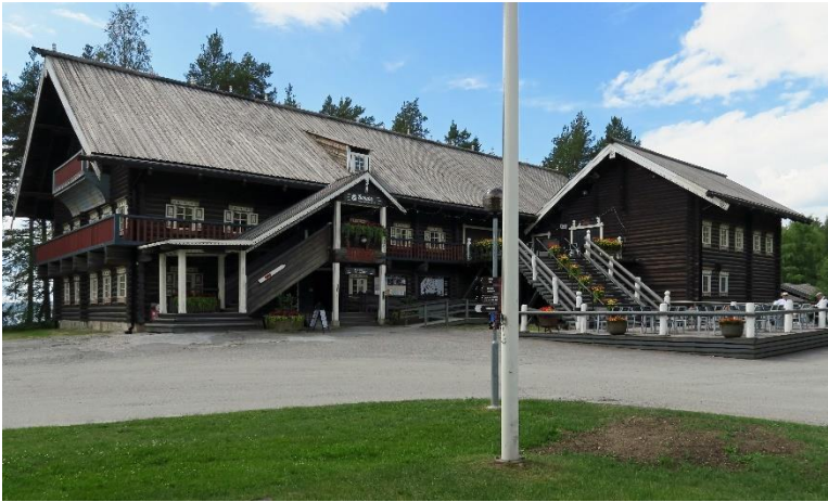
Kuva 41. Valokuva Bomban talon pääsisäänkäynnistä. Kuvakulma lounaaseen.
