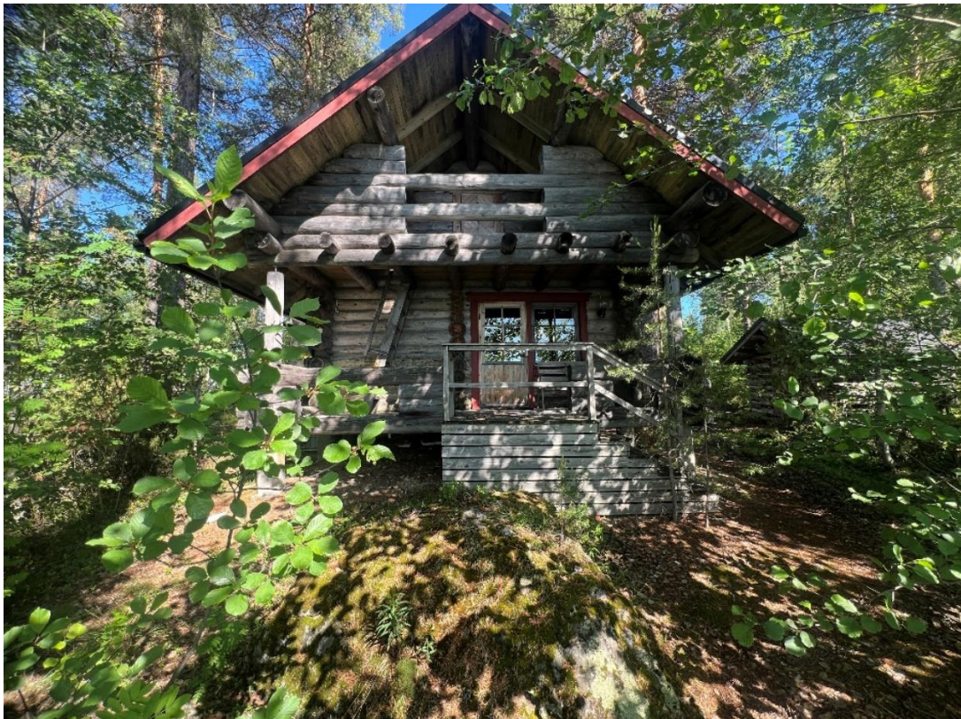
Kuva 55. Rakennus etelästä rannan puolelta.
