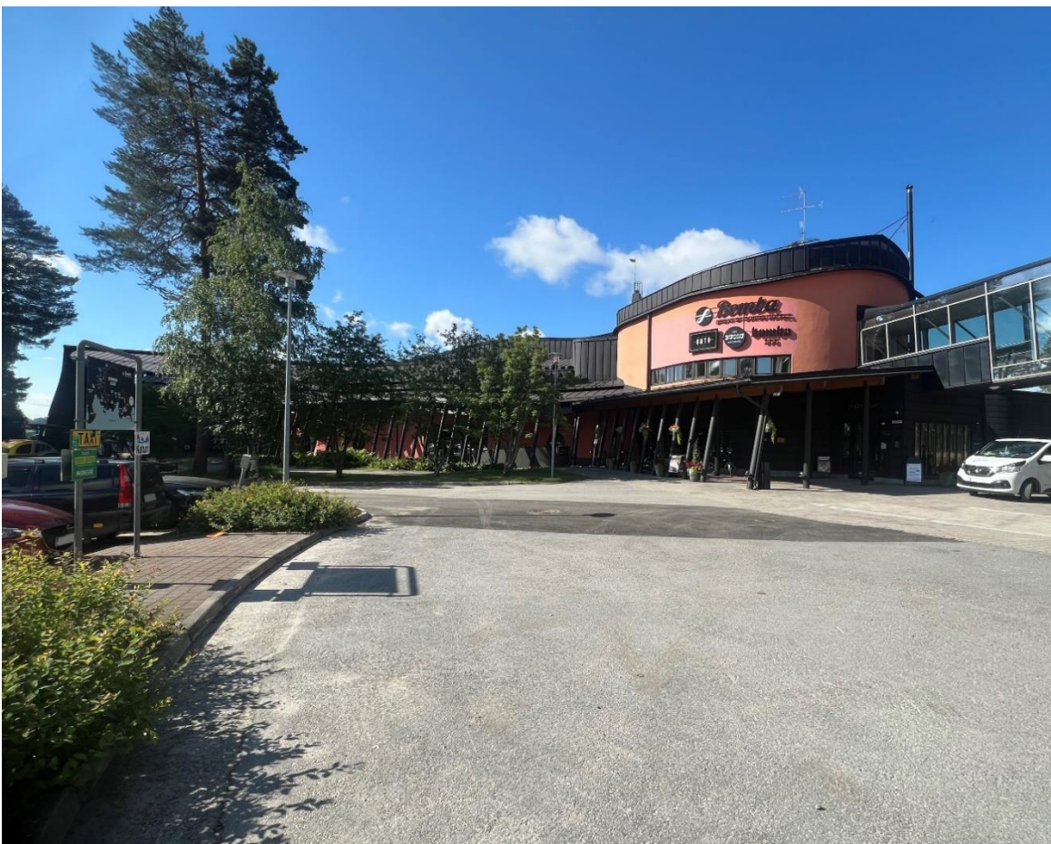
Kuva 62. Kylpylärakennuksen sisäänkäynti. Oikealla näkyvissä lasinen kulkusilta vuonna 2017 rakennettuun laajennusosaan. Kuvakulma lounaaseen.
