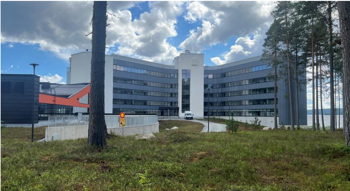
Kuva 61. Vuoden 2024 laajennusosa kuvattuna pohjoisesta, takana järvi. Vasemmalla kylpylä-rakennus.
