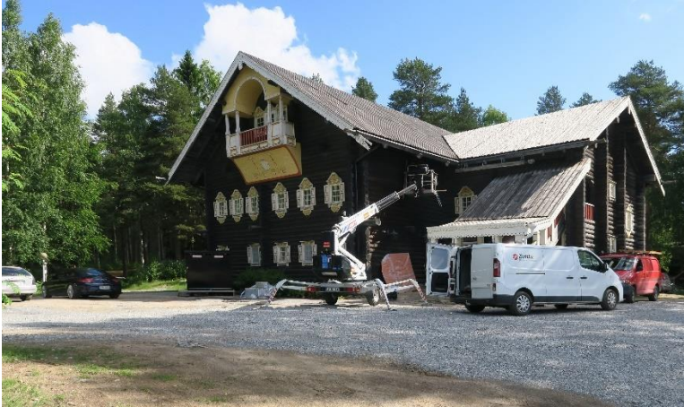
Kuva 32. Valokuva rakennuksesta sisäänkäynnin puolelta. Kuvakulma koilliseen.
